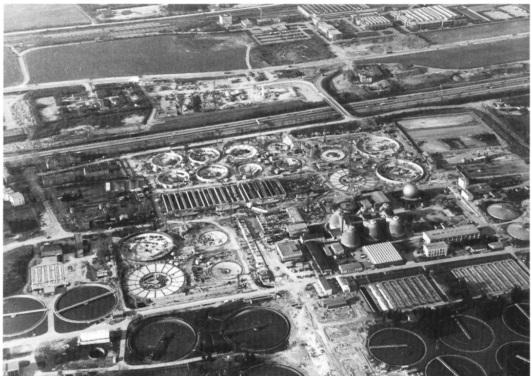
Bild 1. Blick auf die im Bau befindliche 2. Stufe des Klärwerks München I, Biologische Reinigungsanlage (Mitte), die Bundesautobahn München–Nürnberg und die Hilfsbrücke darüber zur Baustelleneinrichtung (Freigegeben Reg. v. Obb. G4/M10516C).
