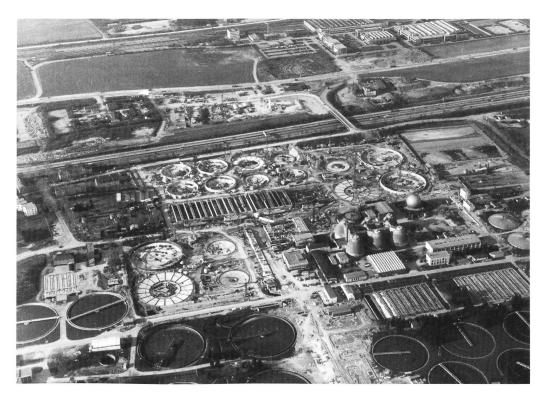
Bild 1. Blick auf die im Bau befindliche 2. Stufe des Klärwerks München I, Biologische Reinigungsanlage (Mitte), die Bundesautobahn München-Nürnberg und die Hilfsbrücke darüber zur Baustelleneinrichtung (Freigegeben Reg. v. Obb. G4/M10516C).
