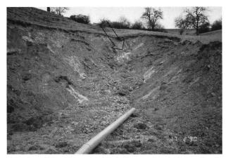
Bild 4. Der klüftige Molassefels (Pfeil) führte zu einer kritischen Vernässung des Deckschichtmaterials von unten.
