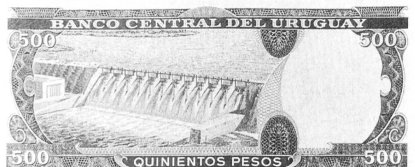
Figure 24. En Uruguay, le barrage de type poids contrefort Dr Gabriel Terra, achevé en 1946, a été aménagé sur le fleuve Negro.
