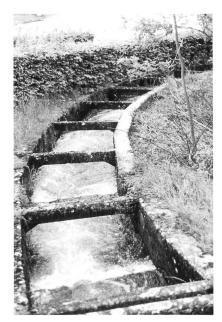
Bild 11. Beckenpass beim Aarekraftwerk Hagneck.
