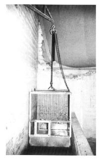
Bild 8. Reuse zur Fischzählung im Beckenpass des Aarekraftwerkes Flumenthal.
