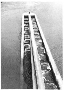
Bild 7. Beckenpass des Mosel-Kraftwerks Fanken. Anordnung im Heck des Trennpfeilers zwischen Wehr und Zentrale.
