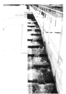
Bild 12. Beckenpass beim Reusskraftwerk Windisch
