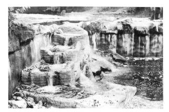
Bild 14. Beckenpass in einem Absturzbauwerk der Töss bei Winterthur.
