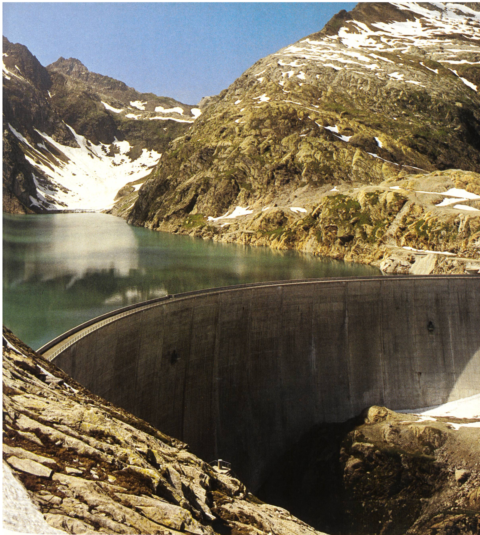
Bogenstaumauer und Stausee Cavagnoli der Maggia Kraftwerke AG.
