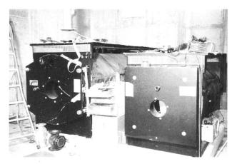
Bild 5. Ansicht der zwei im Werkhof Unterrikon installierten Heizkessel. Der Hauptkessel ist für umweltfreundlichen LOW-NO<sub>x</sub>-Betrieb ausgerüstet. Rund 32% des Wärmebedarfs werden durch diese Heizungsanlage gedeckt, der Rest mittels Abwasser/Wärmepumpen.
