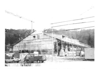
Bild 1. Rohbauansicht des neuen Werkhofes Zell-Rikon im Tösstal, in welchem sich zwei Wasserspeicher von je 19 m³ Inhalt zur Energiespeicherung der von der Gemeinde Zell genutzten Tösstal-Kanalisationsabwärme befinden. (Fotos: Werner Peyer)
