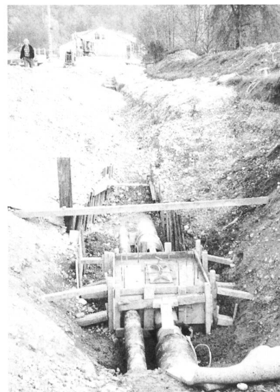
Bild 3, rechts. Um einen praktischen Betrieb zu gewährleisten, wurden mehrere Kontrollöffnungen in den rund 250 m langen Wärmetauscher integriert. Im Hintergrund ist der neue Werkhof der Gemeinde Zell mit den sich dort befindenden Wärmepumpen zu erkennen.
