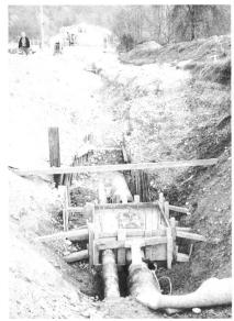
Bild 2, links. In der Gemeinde Zell-Rikon im zürcherischen Tösstal geht man bei der Energienutzung neue Wege und entzieht mittels solcher Doppelrohr-Wärmetauscher der öffentlichen Kanalisation überschüssige Wärme
