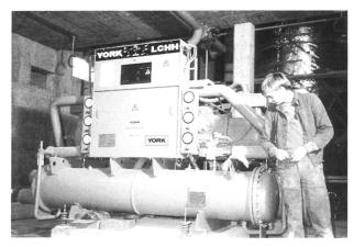
Bild 4. Zwei solcher Wärmepumpen à je 270 kW Wärmeleistung wurden im Untergeschoss des neuen Werkhofs in Unterrikon installiert.
