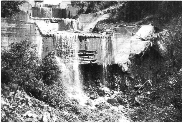
Bilder 2 oben und 3 unten. Die Bilder zeigen zwei im Gürbeoberlauf unterkolkte und beschädigte Betonsperren nach dem Unwetter vom 29. Juli 1990. Die dazwischen gelegenen alten Sperren wurden vollständig ausgeräumt, das Bachbett um mehrere Meter abgesenkt. Von den rund 140 Sperren im Oberlauf der Gürbe wurden 80 vollständig zerstört oder so stark beschädigt, dass sie ersetzt werden müssen.
