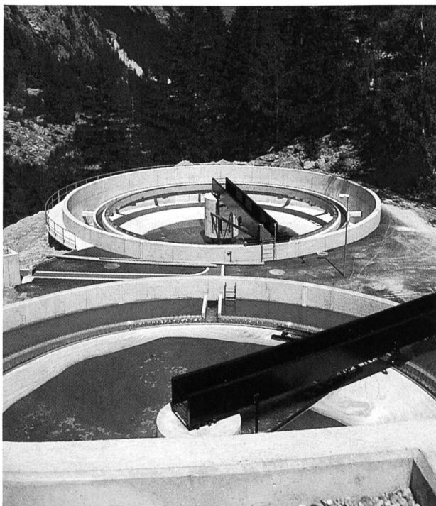
Bild 6. Die beiden Nachklärbecken.
