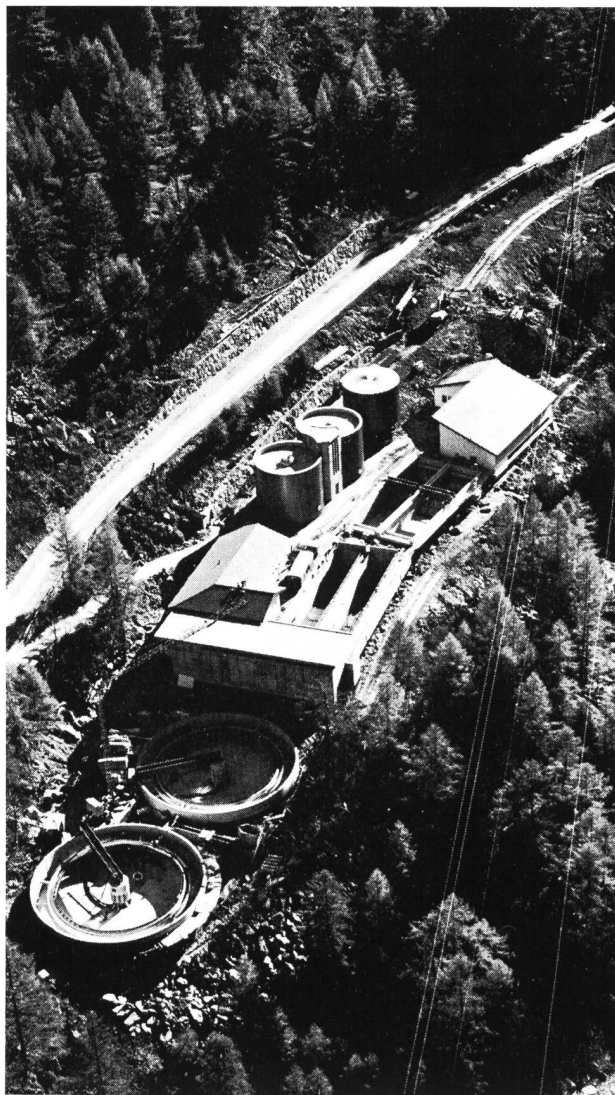
Bild 1. Übersicht über die Abwasserreinigungsanlage Saastal. Von vorne nach hinten: Nachklärbecken, Schlammdeponie, Betriebsgebäude, Belüftungsbecken, Vorklärbecken, Nachfaulraum, Faulraum, Gasometer-Eindicker, belüfteter Sandfang, Rechengebäude.
