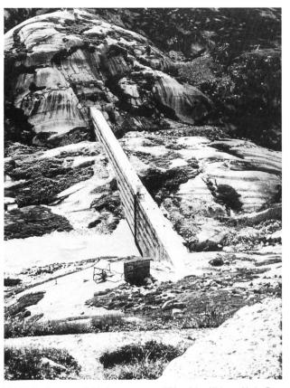
Bild 20. Hochwasserrückhaltesperre von 1930 auf der Albigna-Alp im Bergell (Foto  $\it E. Brügger, Z$ ürich).
