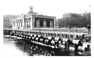
Bild 19. Rolladen-Regulierschützen am Pont de la Machine in Genf; im Hintergrund das Gebäude, in welchem die von *J.-M. Cordier* eingerichteten Wasserräder und Pumpen die Stadt 1843–1886 mit Wasser versorgten (Foto *J. Wahl*, Genève).
