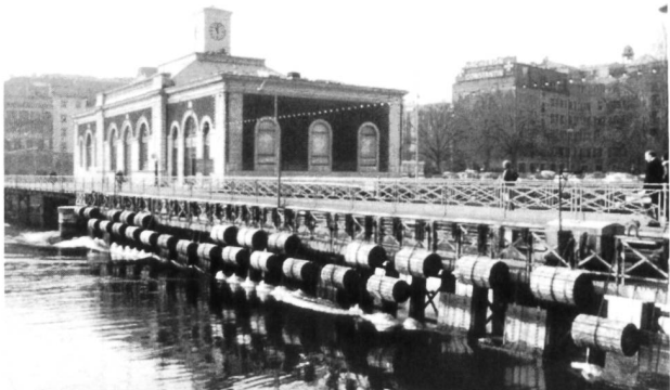
Bild 19. Rolladen-Regulierschützen am Pont de la Machine in Genf; im Hintergrund das Gebäude, in welchem die von J.-M. Cordier eingerichteten Wasserräder und Pumpen die Stadt 1843–1886 mit Wasser versorgten (Foto J. Wahl, Genève).
