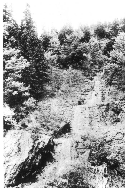
Bild 16. Verbauung des Gadenmattbaches bei Lungern, 15 km südwestlich von Sarnen, bei Bauende 1890 (links) und heute (Fotos Tiefbauamt, Sarnen/OW).
