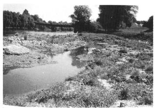
Bild 1. Staustufe Vohburg der Donau-Wasserkraft AG, einer Tochtergesellschaft der Rhein-Main-Donau AG, München: Die neugestaltete Paarmündung mit Inseln, Flachwasserzonen und Kiesbänken.
