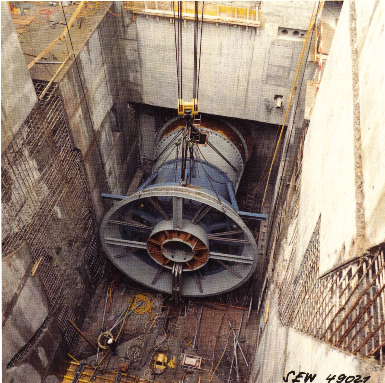
Bild 14. Montage der Mauerringe mit einer Lehre.
