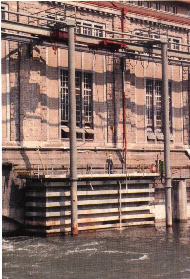
Bild 10. Saugrohrverschluss mit Umsetzkrane.
