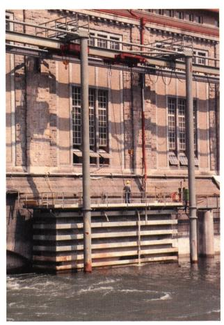
Bild 10. Saugrohrverschluss mit Umsetzkran.
