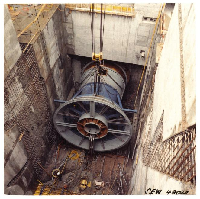
Bild 14. Montage der Mauerringe mit einer Lehre.
