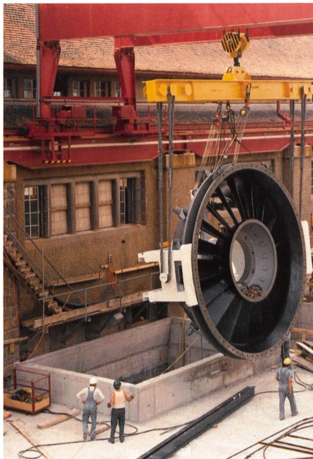
Bild 22. Beim Einfahren des 50,4 t schweren Leitapparates in die Maschinenruhr 1.
