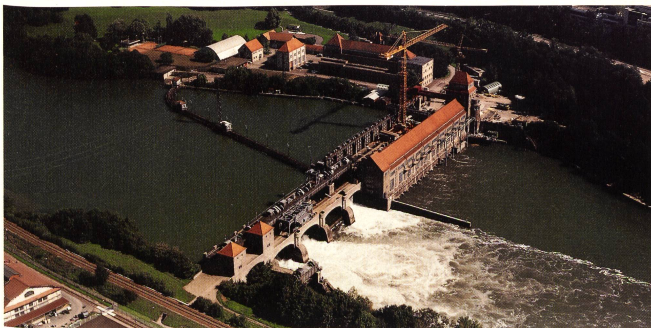
Bild 1. Rheinkraftwerk Laufenburg, bisheriger Zustand mit Aussenrechen.
