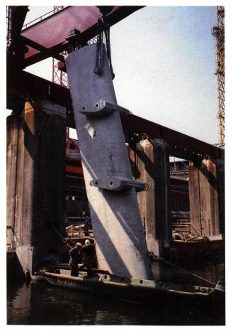
Bild 11. Montage einer Schrägstütze des Einlaufrechens.
