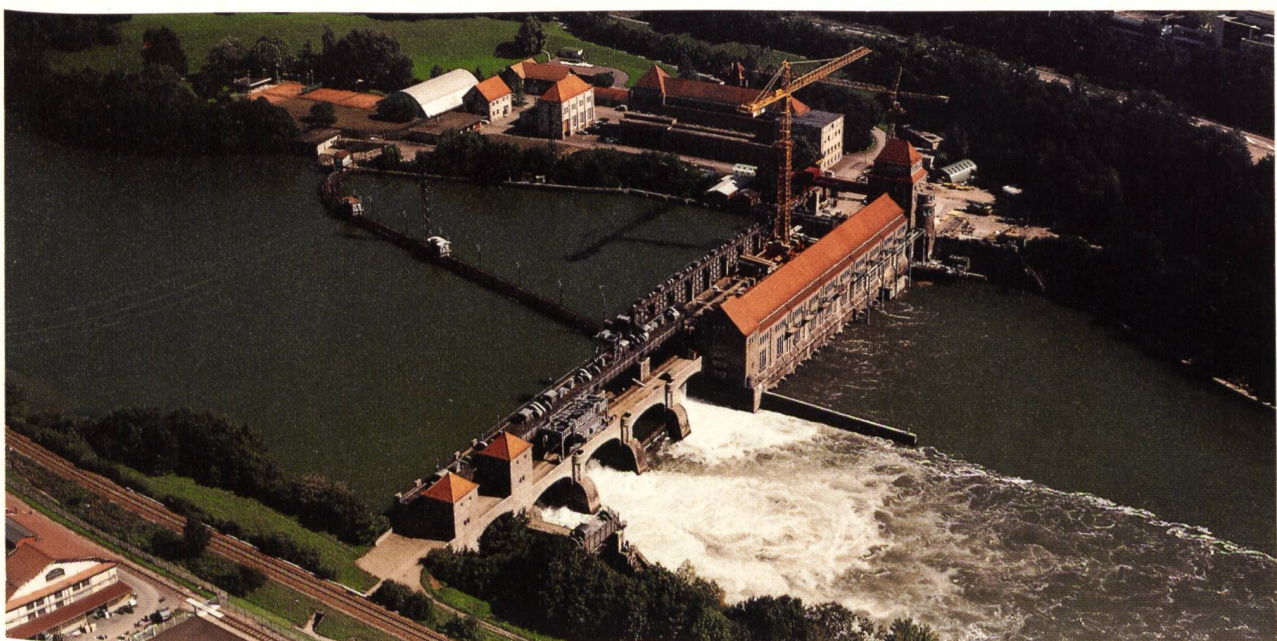
Bild 1. Rheinkraftwerk Laufenburg, bisheriger Zustand mit Aussenrechen.
