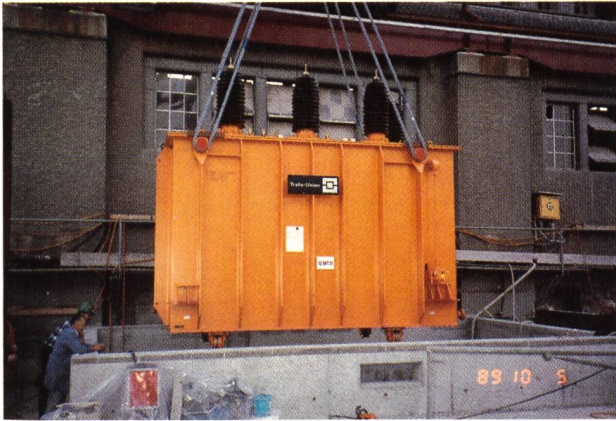
Bild 16. Absenken eines Maschinentransformators in den Gruppenschacht.
