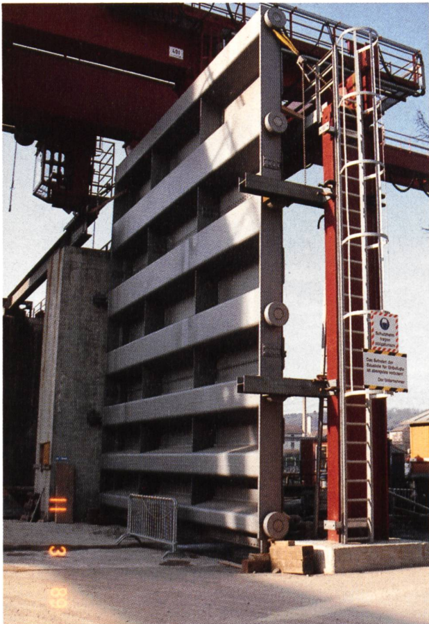
Bild 8. Der neue Rolldammbalken nach der Endmontage.
