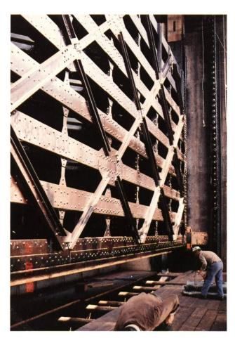
Bild 19. Untere Schützentafel im Wehrfeld 1 nach dem Auftrag des Korrosionsschutzes.
