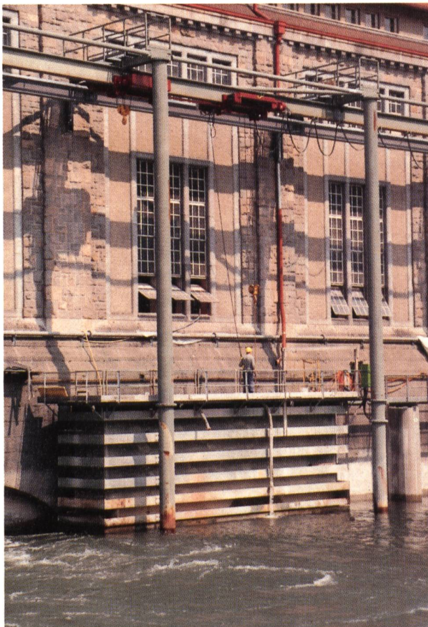
Bild 10. Saugrohrverschluss mit Umsetzkran.
