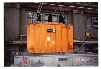
Bild 16. Absenken eines Maschinentransformators in den Gruppenschacht.
