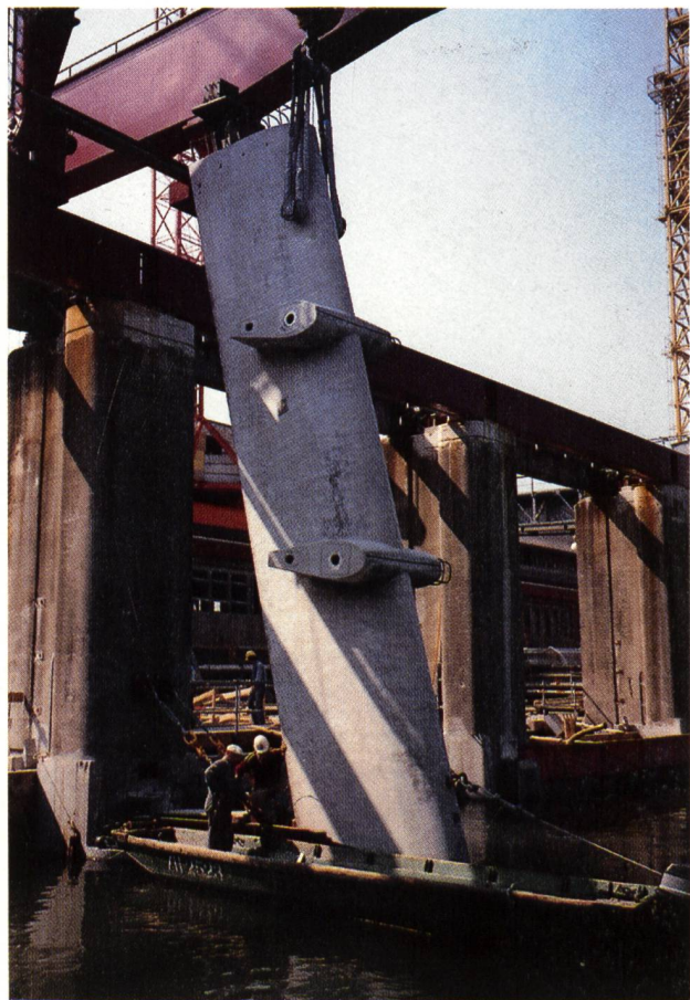
Bild 11. Montage einer Schrägstütze des Einlaufrechens.
