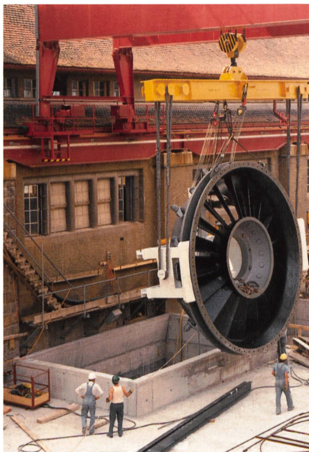
Bild 22. Beim Einfahren des 50,4 t schweren Leitapparates in die Maschinengrube 1.
