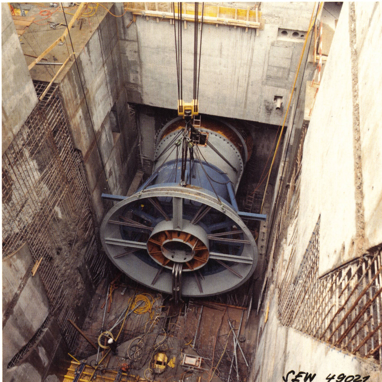
Bild 14. Montage der Mauerringe mit einer Lehre.
