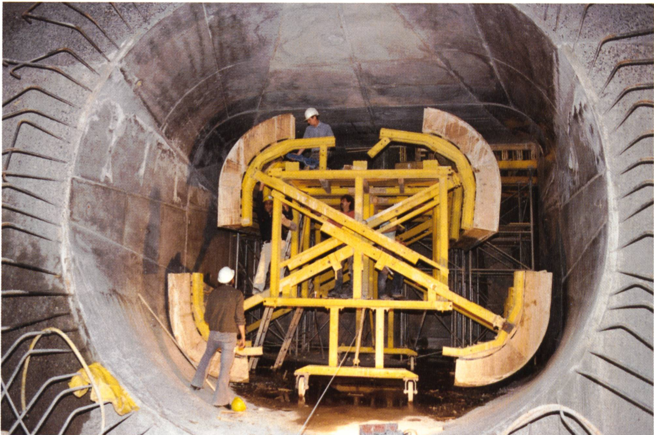
Bild 13. Saugrohr, Zustand während des Umbaus.
