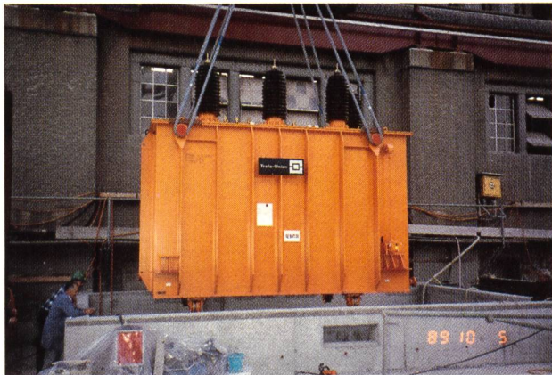
Bild 16. Absenken eines Maschinentransformators in den Gruppenschacht.
