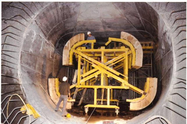
Bild 13. Saugrohr, Zustand während des Umbaus.
