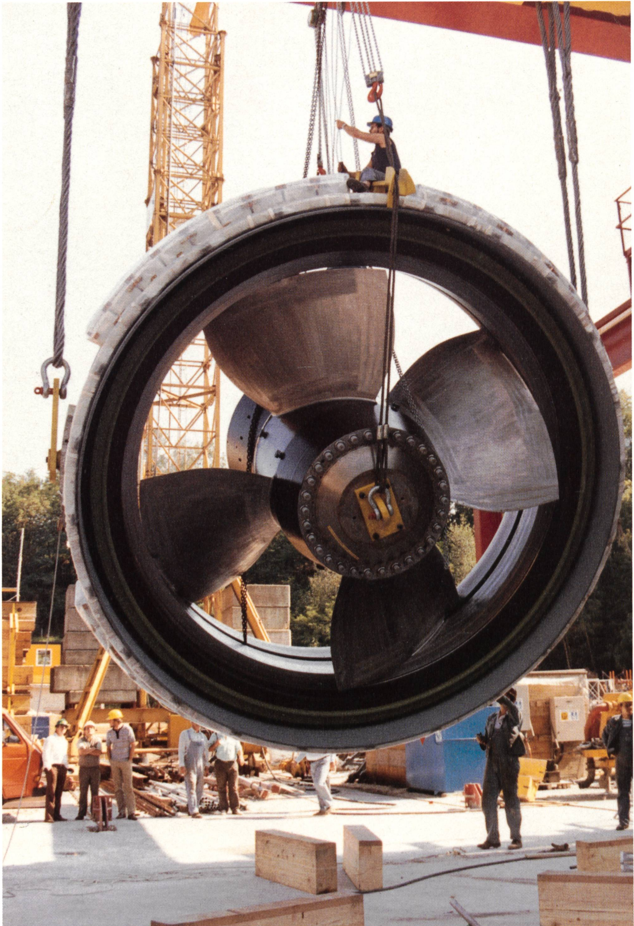
Bild 15. Das Laufwerk vor dem Einfahren in den Gruppenschacht.
