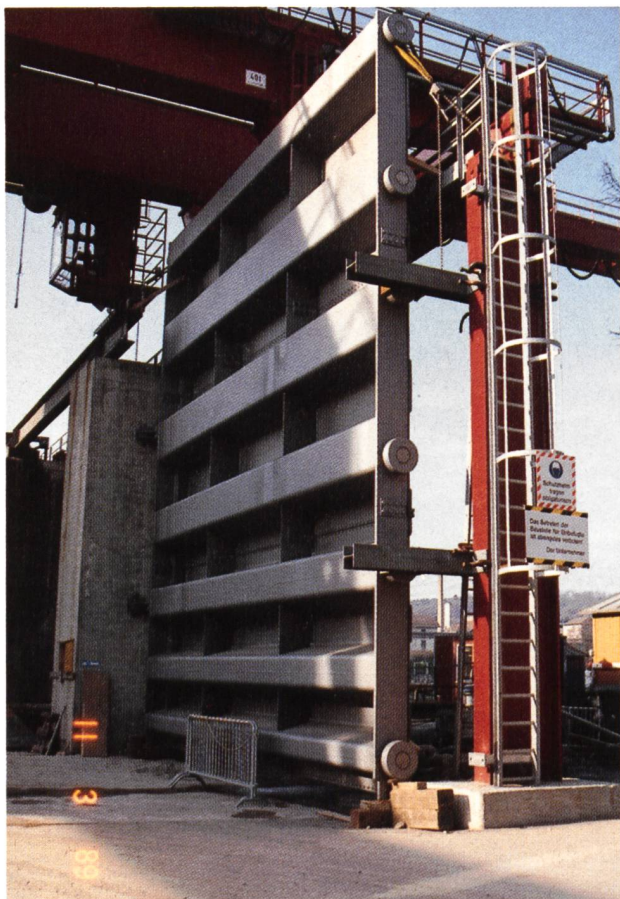
Bild 8. Der neue Rolldammbalken nach der Endmontage.
