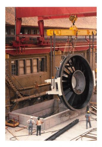
Bild 22. Beim Einfahren des 50,4 t schweren Leitapparates in die Maschinengrube 1.
