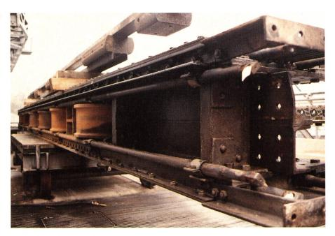
wendung aller noch brauchbaren Bestandteile erneuert, auf Wälzlagerung und auf ein Schmiersystem mit Rückführung umgebaut. Auf diese Weise werden zukünftig Schäden an den Dichtungen der Lager auch im eingebauten Zustand beim Schmierservice entdeckt und es sind keine weiteren Unterhaltsarbeiten notwendig, solange die Schmierung einwandfrei funktioniert.
