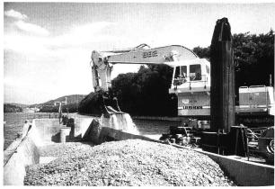
Bild 6. Hydraulikbagger auf Stelzenponton.
