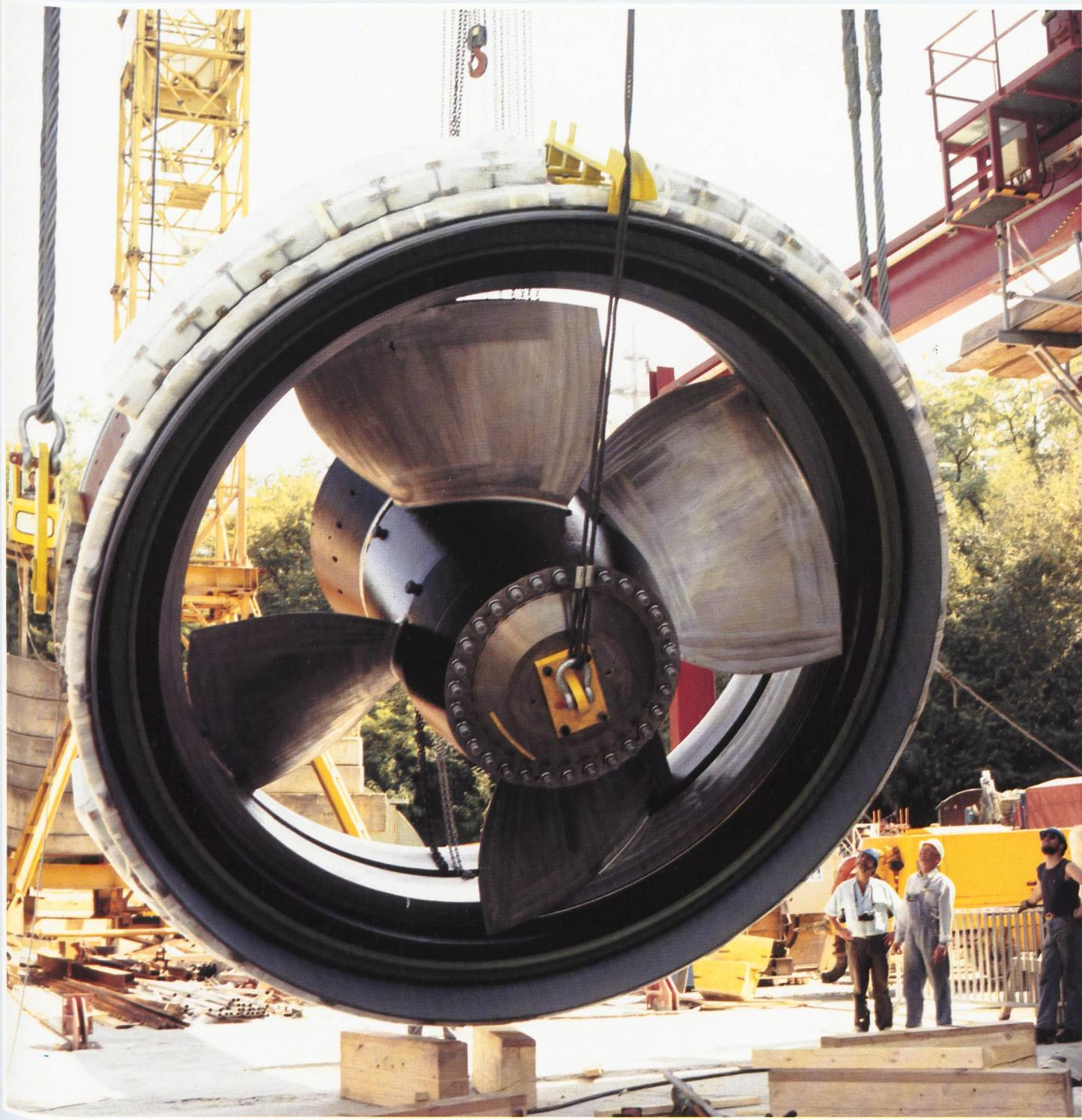
Ausbau Rheinkraftwerk Laufenburg: Laufrad der Maschinengruppe 1 vor dem Einbau.
