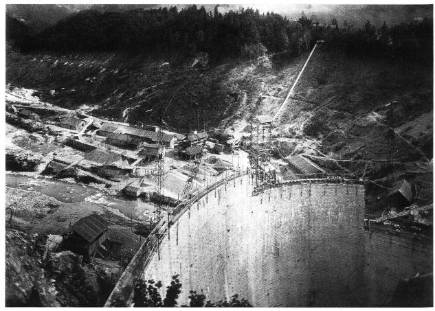
Bauaufnahme der 1919/20 erstellten Staumauer Montsalvens, 22 km südlich von Freiburg. Von Heinrich E. Gruner (1873–1947) projektiert, war sie die erste nicht mehr über die ganze Höhe gleichmässig gekrümmte Bogenmauer Europas.
