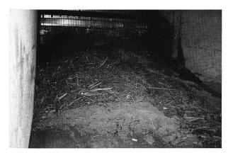
Bild 9. Geschiebeablagerung in den Turbineneinläufen.
