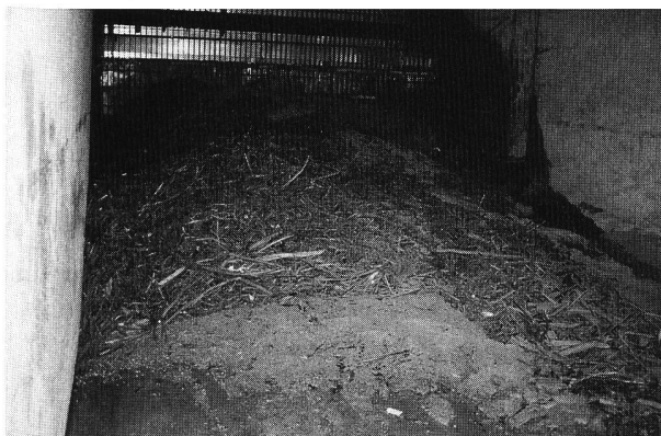
Bild 9. Geschiebeablagerung in den Turbineneinläufen.
