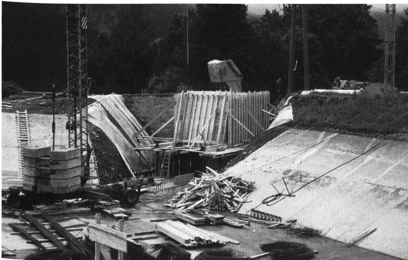
Bild 3. Bau des Entnahmebauwerks im Ausgleichsbecken Luchsberg für das Kraftwerk der Spinnerei Murg AG.
