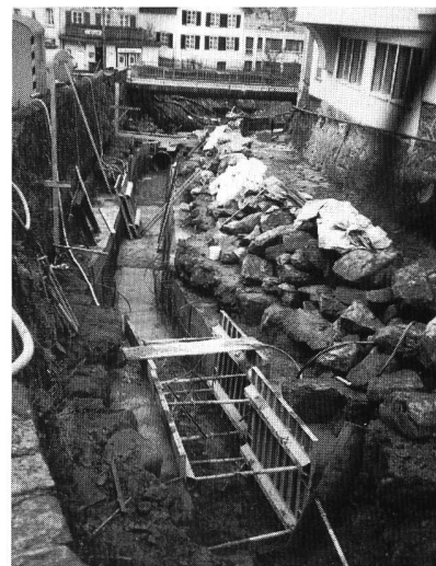
Bild 4. Bau des Druckleitungsabschnitts im Murgbachbett.
