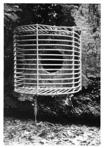
Bild 10. Auslass einer kleinen Sperre: Starke Unterspülungen, welche die Funktion der Anlage in Frage stellen, müssen behoben werden. Der Korbrechen muss genügend gross sein, damit das viele Laub den Rechen nicht verstopfen kann.
