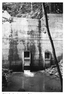
Bild 9. Auslasstyp Öffnung: Ottenhusen (LU). Der Blick auf die Luftseite der Mauer zeigt die auf den berechneten Ausfluss verblendete Rechtecköffnung. Rechts davon ist eine Notentleerungsöffnung angeordnet.
