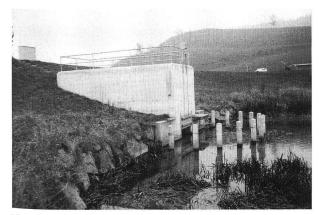
Bild 7. Auslasstyp Mönch: Turbenthal (ZH). Vor der verblendeten Auslassöffnung des Schachtbauwerks halten Betonpfähle das grobe Geschwemmsel fern. Erreicht der Aufstau die Mauerkrone des Bauwerks, so wirkt der Überfall in den Schacht als Hochwasserentlastung.
