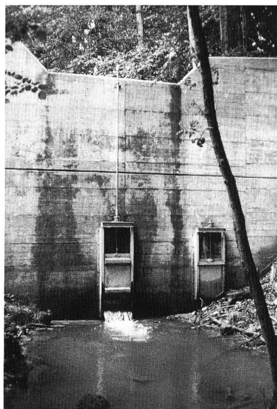
Bild 9. Auslasstyp Öffnung: Ottenhusen (LU). Der Blick auf die Luftseite der Mauer zeigt die auf den berechneten Ausfluss verblendete rechteckige Öffnung. Rechts davon ist eine Notentleerungsöffnung angeordnet.
