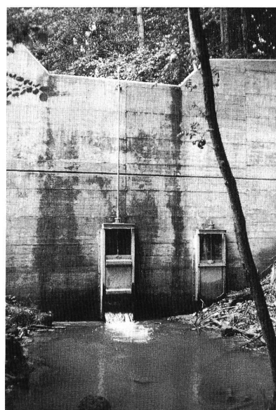
Bild 9. Auslastungstyp Öffnung: Ottenhusen (LU). Der Blick auf die Luftseite der Mauer zeigt die auf den berechneten Ausfluss verblendete Rechtecköffnung. Rechts davon ist eine Notentleerungsöffnung angeordnet.
