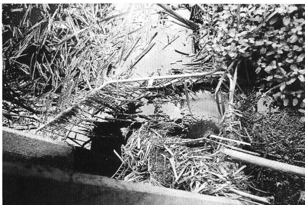
Bild 12. Auslass eines mönchartigen Bauwerks: Die Auslassöffnung des mönchartigen Bauwerks ist mit Schilf zum Teil verstopft. Der Blick von oben auf die Einlaufrechen macht deutlich, dass bei zu kleinen Abmessungen des Fein-/Grobrechen schon bei wenig Geschwemmselanfall der Rechen zu Verklausungen neigt.
