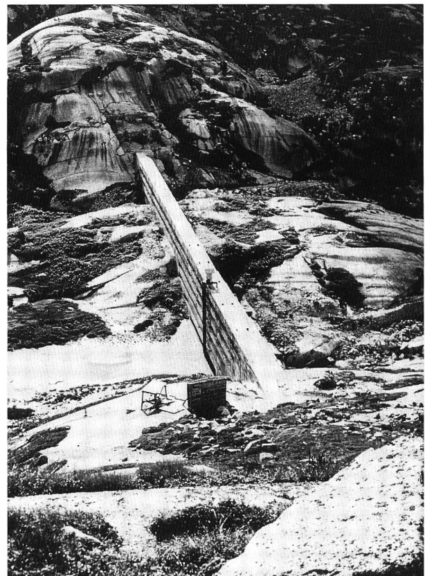
Bild 1. Das erste Hochwasserrückhaltebecken der Schweiz: Albigna 1929/30. In den Jahren 1956 bis 1959 wurde die Sperre durch die heutige Staumauer ersetzt, die auch den Hochwasserrückhalt übernimmt.
