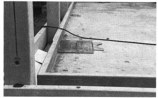
Bild 1. Hallenboden als Tertiärbecken mit Plattenrand vor den Stützen und gradliniger Aufkantung – aus wasserdichtem Beton.
