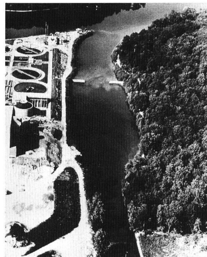
Bild 6. Der Geschiebesammler an der Emme vor der Mündung in den Stauraum des Kraftwerks Flumenthal.
