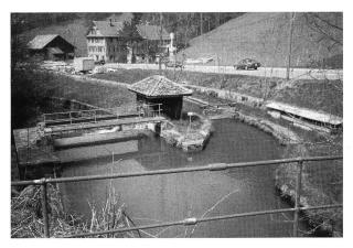
Bild 4. Das Wehr und der Kanaleinlauf des Kraftwerks Neuägeri wurden für die Spinnerei Neuägeri 1915 gebaut. Nach Aufgabe der Spinnerei wird der hier produzierte Strom ins allgemeine Netz eingespiesen.
