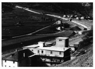
Bild 9. Gepflästerter Ableitungskanal auf dem Murkegel von Privilasco mit Rückhaltebecken im Bereiche des Vorfluters, das eine Kapazität von ca. 10000 m³ hat. (Foto *G. Paravicini,* Poschiavo)
