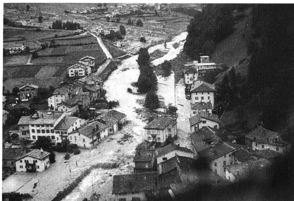
Bild 4. Situation des Poschiavino am 19. Juli 1987 morgens am oberen Ortseingang von Poschiavo. Das mit Schutt eingedeckte Bachgerinne leitete das Wasser in die Strassen der Ortschaft. Oben links ist der übermurtete Varunakegel sichtbar. (Luftbild A. Riedo, Poschiavo)
