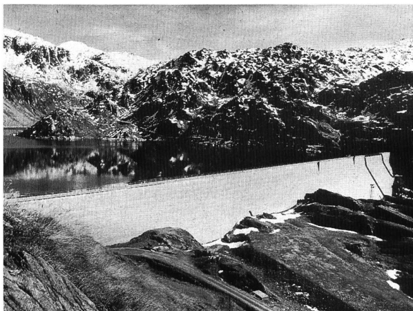
Figura 4. Diga Sella, vista verso est, Passo Sella, Unteralp, Val Canaria. Bild 4. Staumauer Sella, Blick gegen Osten, Sellapass, Unteralp, Val Canaria.
