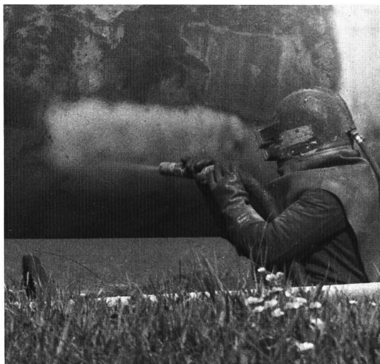
Figura 2. Operaio della ditta Darani munito della speciale attrezzatura, intento alla pulizia al getto di sabbia della superficie esterna.
