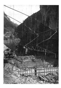
Bild 13. Betonierung 1924 der Staumauer Schräh mittels Giessrinnen (Foto *E. Schnitter,* Itschnach/ZH).
