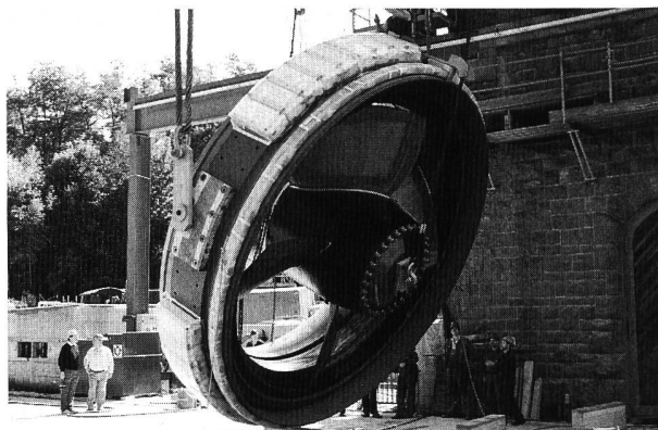
Das Rheinkraftwerk Laufenburg wird zurzeit erneuert. Der im April 1987 genehmigte Umbau soll 1993 fertig werden. Die bis zu 60 Jahre alten 10 Francis-Maschinen werden durch 10 Straflo-Maschinen größerer Leistung ersetzt. Am 11. April 1990 konnte die erste Gruppe dem Betrieb übergeben werden. Mit einem Gesamtaufwand von über 300 Mio Fr. (Basis 1986) kann die Energieproduktion um über 30% auf 680 Mio kWh im Mitteljahr gesteigert werden.
