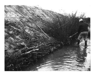
Bild 7. Ein Arbeiter verlegt die Spreitlagen. Die Faschinenwalzen sind be-
