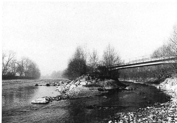
Bild 3. Früher mündete hier nur der Winkelbach in die Reuss. Zusammen mit dem Bau der Nationalstrasse wurde der Rotbach mit dem Winkelbach vereinigt und die Einmündung des Rotbaches um etwa 900 m flussabwärts verlegt.
