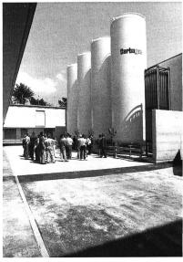
Bild 2. Lagertanks für flüssigen Sauerstoff.
