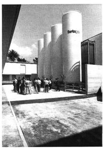
Bild 2. Lagertanks für flüssigen Sauerstoff.
