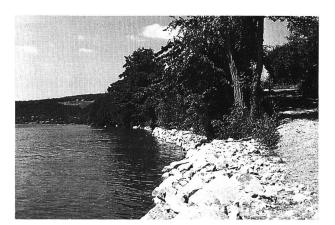
Bild 4. Gleicher Standort wie Bild 3. Schon im folgenden Sommer präsentiert sich die sanierte und für die Bauarbeiten teils gerodete Böschung in saftigem Grün. Auch hier liegt der Wasserspiegel tief. Bei maximalem Stauspiegel wäre lediglich noch die obere Steinreihe sichtbar.
