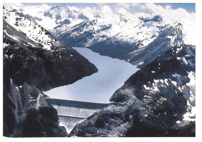
Flugaufnahme der 285 m hohen Gewichtsmauer der Grande-Dixence AG mit dem Stausee. Das Nutzvolumen beträgt 400 Mio m³. Für eine optimale Nutzung des Wassers legte die Grande-Dixence AG das Projekt Cleuson-Dixence vor, das auf Seite 2f. beschrieben ist.
