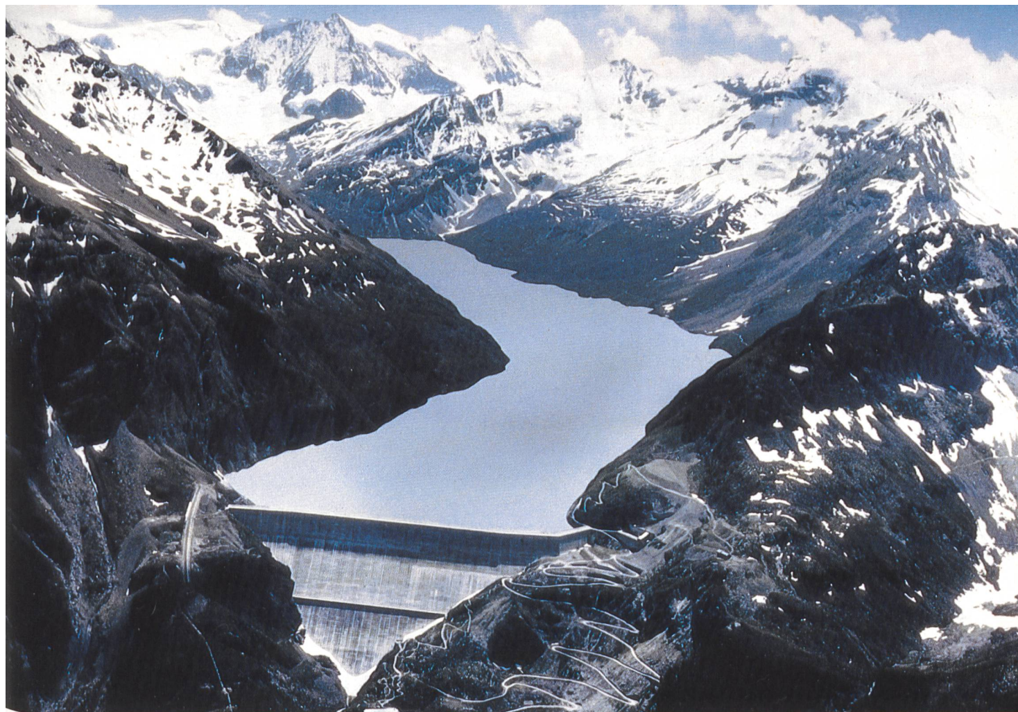
Flugaufnahme der 285 m hohen Gewichtsmauer der Grande-Dixence AG mit dem Stausee. Das Nutzvolumen beträgt 400 Mio m 3 . Für eine optimale Nutzung des Wassers legte die Grande-Dixence AG das Projekt Cleuson-Dixence vor, das auf Seite 2f. beschrieben ist.
