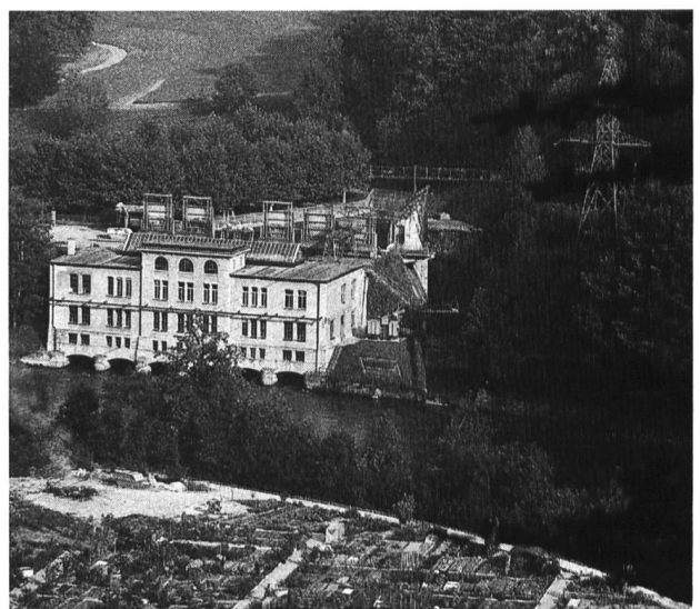
Bild 14–4. Die alte Zentrale Felsenau während des Umbaus. Rechts ist die Baugrube für das neue Maschinenhaus zu erkennen.
