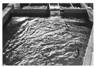
Bild 7.2–13. Durchfluss von 80 m³/s durch das Vorbecken bei Entlastungsbetrieb der Rohrturbine. Der Wasserspiegel im Vorbecken sieht etwas rauh aus, was auf eine intensive Durchströmung deutet.
