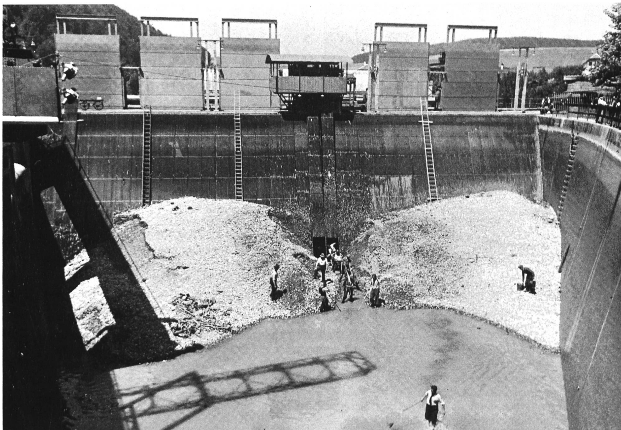
Bild 10–5. Feinrechen vor dem Turbineneinlauf. Zwischen den beiden Haufen angeschwemmten Gerölls wurde ein Einschnitt ausgeräumt, um das Wasser ableiten zu können. Zustand vor dem Umbau 1978.
