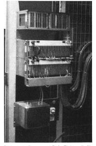
Bild 11-4. Procontrol-P13: Elektronik für Sequenzer und Alarmierung. Gebermodule und Synchrotakt III.
