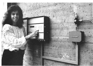
Bild 5. Füllstandsmessung eines Stausees mit dem Präzisionsdruckmessgerät W1Q.
