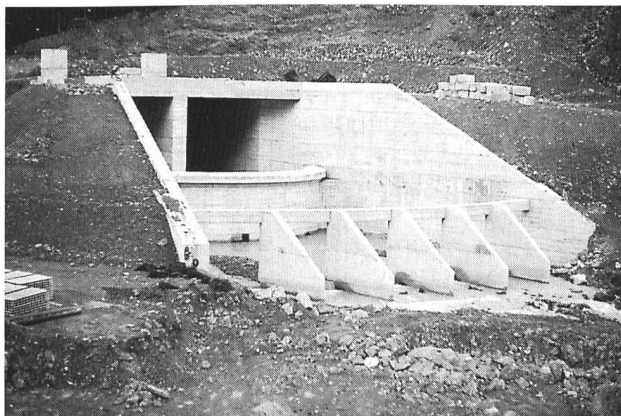
Bild 3. Auslaufbauwerk der Stollen. Blick vom Unterwasser auf die Gegenschwelle des Tosbeckens (Foto A. Huber).
