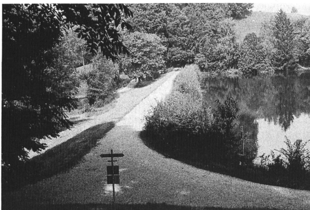
Bild 3. Im Westen wird der Gübsensee ebenfalls durch einen Erddamm abgeschlossen. Auch hier musste der Baumbewuchs entfernt und eine Betontrennwand in die Dammitte eingelassen werden.
