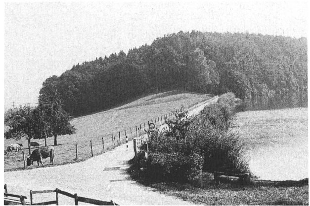
Bild 2. Der Norddam des Gübsensees, von Westen her gesehen. Damit seine Standfestigkeit und Dichtigkeit auch weiterhin gewährleistet ist, mussten auf dem Damm gewachsene grössere Bäume entfernt werden. In der Mitte des Dammes (unter dem Weg) wurde eine 2,5 m tiefe Beton-trennwand eingefügt, um den Damm abzudichten.
