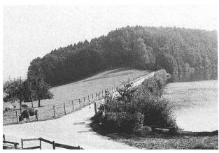
Bild 2. Der Norddamm des Gübsensees, von Westen her gesehen. Damit seine Standfestigkeit und Dichtigkeit auch weiterhin gewährleistet ist, mussten auf dem Damm gewachsene grössere Bäume entfernt werden. In der Mitte des Dammes (unter dem Weg) wurde eine 2,5 m tiefe Betontrennwand eingefügt, um den Damm abzudichten.
