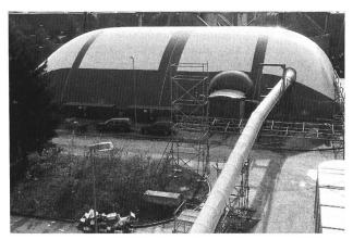
Bild 2. Die Traglufthalle für die Klärschlamm-Entgasung mit dem Förderband zum Transport des entwässerten Schlammes von der Entwässerungsanlage in die Halle.
