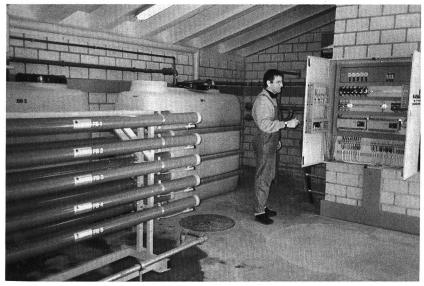
Bild 1. 10 Module zu 18 Membranrohren (links im Bild) mit einer effektiven Membranfläche (Nutzfläche der Gesamtanlage) von 16 m². Anlageleistung 500 I/h Permeatabgabe.
