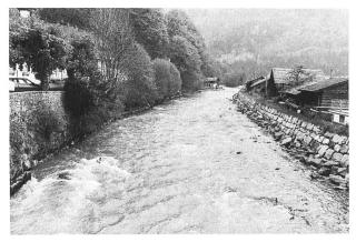
Bild 2. Die Lütschine bei Gsteig. Blick flussaufwärts. Links bildet der Fuss des Aenderbergs ein natürliches Ufer, rechts wurde ein starker Damm gebaut, um die angrenzenden Häuser und das Bödeli vor Überschwemnungen zu schützen.
