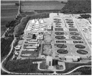
Bild 1. Das Klärwerk München II mit 32 rissefreien Betonbauwerken ohne Dehnungsfugen.
