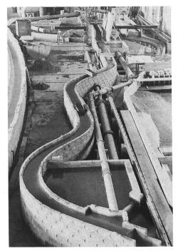
Bild 3, links. Sektion Erzeugung mit Exponaten der Schweizer Industrie: Turbinen, Generatoren, Druckleitungen und Abschlussorgane. Schifflibach: Länge 1800 m, Fliessgeschwindigkeit 1,4 bis 1,6 m/s, maximale Förderkapazität 1080 Personen pro Stunde (Foto Ringier Dokumentationszentrum). Bild 4, rechts. Das hydraulische Modell des Schifflibachs an der Versuchsanstalt für Wasserbau der ETH (Foto VAW).
