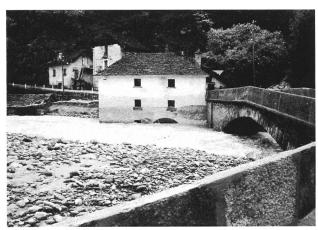
Bild 5. Unterlauf der Rovana bei Cevio. Zustand nach dem Hochwasser im Herbst 1979. Die Erhöhung der Flusssohle infolge starker Geschiebeablagerung betrug über 6 m.
