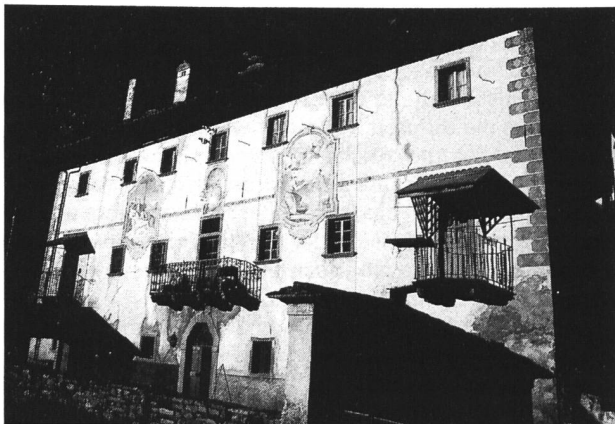
Bild 2. Patrizierhaus von Campo Vallemaggia mit Rissen in der Fassade als Folge der grossen Bewegungen der Rutschung.
