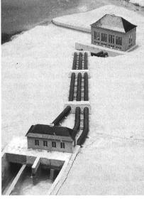
Bild 1, links. Das Wasserbaumodell 1:50 an der Landesausstellung 1939. Links ein Hochdruckspeicherwerk, in der Mitte ein Mitteldrucklaufwerk, rechts zwei geschiebeführende Wildbäche, die im See ein Delta bilden (Foto VAW).
