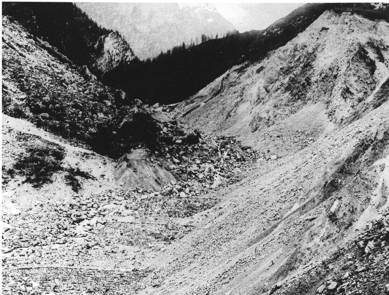
Bild 3. Erste Verbauungen der Rovana am Fuss der Rutschung von Campo Vallemaggia im Jahr 1888.
