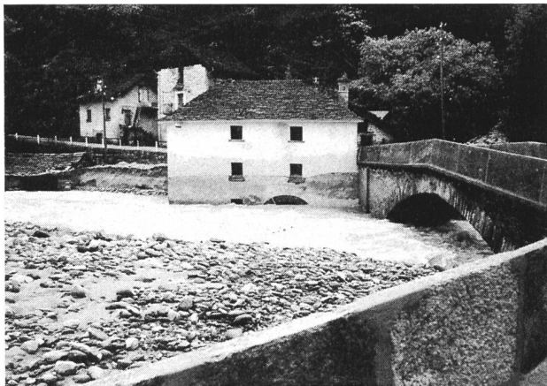
Bild 5. Unterlauf der Rovana bei Cevio. Zustand nach dem Hochwasser im Herbst 1979. Die Erhöhung der Flusssohle infolge starker Geschiebeab-lagerung betrug über 6 m.
