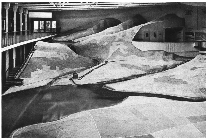
Bild 1, links. Das Wasserbaumodell 1:50 an der Landesausstellung 1939. Links ein Hochdruckspeicherwerk, in der Mitte ein Mitteldrucklaufwerk, rechts zwei geschlebeführende Wildbäche, die im See ein Delta bilden (Foto VAW).
