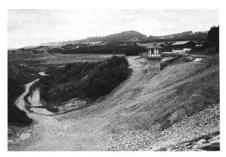
Bild 3. Rottachtalsperre: Schieberschacht; links unten Einlauf zum Grundablass (jetzt Bauumleitung).
