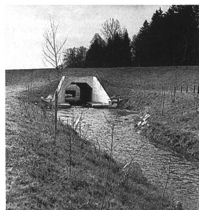
Bild 10. Auslaufbauwerk des Ableitkanals mit Tosbecken.
