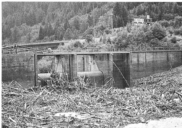
Bild 4. Schwemmholz vor den Klappen der Hochwasserentlastung.
