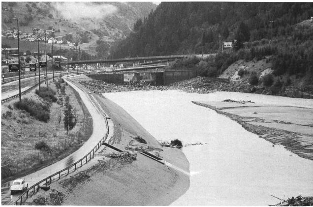
Bild 3. Becken des Falles 3 nach dem Hochwasserereignis.
