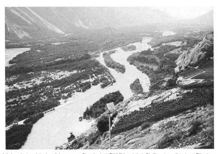
Bild 1, links. Die Rhone im Wallis wurde im letzten Jahrhundert praktisch auf der ganzen Strecke (vgl. Bild 2) korrigiert. Sie fliesst, gesäumt von Büschen und Bäumen, in einem Trapezprofil, dessen Ufer mit einem Blockwurf geschützt ist.
