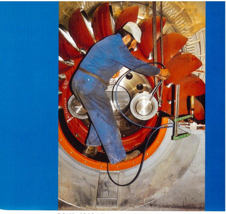
Kraftwerk Ilanz II, Stufe Panix. Montage des Peltonlaufrades auf die Rotorwelle. Die Dehnschrauben M80 werden mit einer hydraulischen Spannvorrichtung um 0,742 mm (± 0,06 mm) in zwei Montageschritten vorgespannt.
