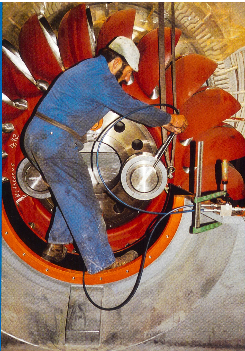
Kraftwerk Ilanz II, Stufe Panix. Montage des Peltonlaufrades auf die Rotorwelle. Die Dehnschrauben M80 werden mit einer hydraulischen Spannvorrichtung um 0,742 mm ( \pm 0,06 mm) in zwei Montageschritten vorgespannt. Die Turbine hat Bell AG, Kriens, geliefert. Das Peltonlaufrad mit 21 Schaufeln hat einen Durchmesser (Schaufelmittle) von 1820 mm. Der dazugehörige Generator wurde von ABB, Baden, geliefert. Der Durchmesser der Welle am Lager beträgt 630 mm, derjenige des Kupplungsflansches 890 mm. Siehe auch Ulrich Olsen und Markus Rennhard : Das neue Kraftwerk Ilanz mit seiner Schwingungsüberwachung, Seite 103ff.
