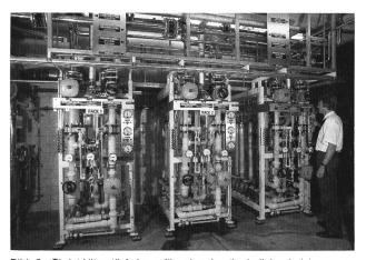
Bild 2. Christ-Ultrastil-Anlage für eine kontinuierliche Leistung von 20 m³/h apyrogenem, sterilem, salzarmem Wasser in einem pharmazeutischen Betrieb. Neben der hohen Temperaturbeständigkeit zeichnen sich die Ultrafiltrationsmodule dieser Anlagen durch hohe mechanische und chemische Beständigkeit und ihre doppelschichtige Membran aus.
