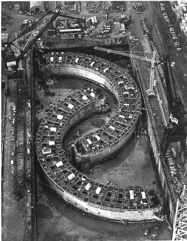
Bild 4. Betonieren des unteren Teils der beiden Wandteilstücke in einem Schiffsdock in den Niederlanden.
