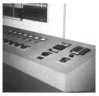
Bild 8. Störungsanzeige mit Lampenfeld (im Vordergrund) in der Steuerzentrale der ARA Finsiedeln
