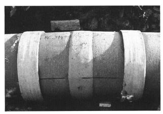
Bild 4. Rohrkrümmer in der 700-mm-GUP-Leitung, bestehend aus einem Krümmerteil, der aus zwei Rohrabschnitten in der Werkstatt zusammengeschweisst und mit einem Wulst verstärkt wurde. Links und rechts ist der Krümmer mit Spezialmuffen ans Rohr angeschlossen.
