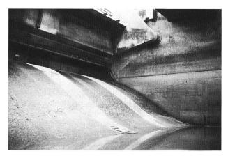
Bild 5. Zustand des Überfallrückens in Wehröffnung 2 im Herbst 1987. Die mit Beton sanierten Stellen sind am Fuss des Überfallrückens gut erkennbar.
