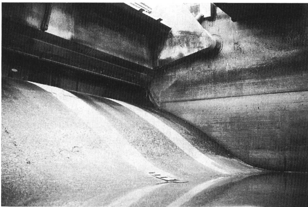
Bild 5. Zustand des Überfallrückens in Wehrröffnung 2 im Herbst 1987. Die mit Beton sanierten Stellen sind am Fuss des Überfallrückens gut erkennbar.
