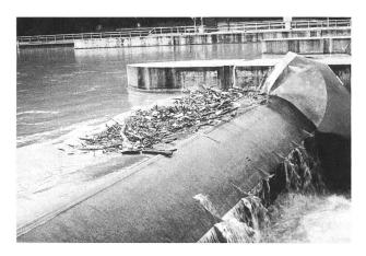
Bild 7. Unterströmte Segmentschütze mit Treibgutansammlung im Oberwasser. Nahe dem seitlichen Schild lässt sich eines der beiden Drehlager der Klappe erkennen.
