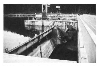
Bild 4. Segmentschütze mit angehobener Klappe. Im Hintergrund die Montagebrücke zum Versetzen der OW-Dammbalken.
